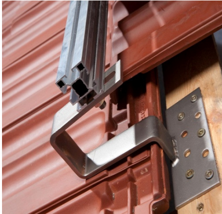
Abb. 7 Befestigung der Montageschiene auf den Dachhaken
